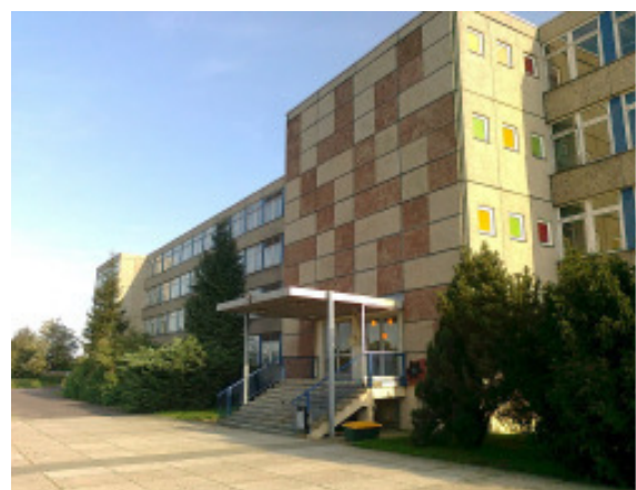
Grundschule Nord „Collmblick“, Zur Krone 51
