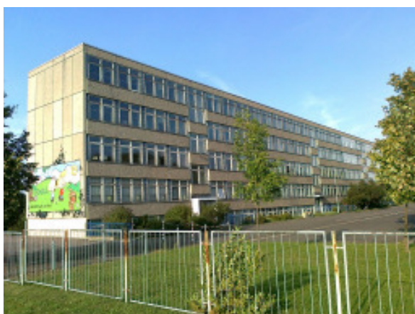
Grundschule Nord „Collmblick“, Zur Krone 51
