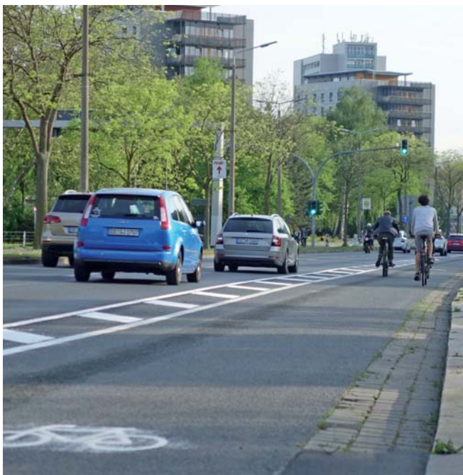
Radfahrstreifen mit zusätzlichem Sicherheitsraum zum fließenden Verkehr auf der St. Petersburger Straße in Dresden.
