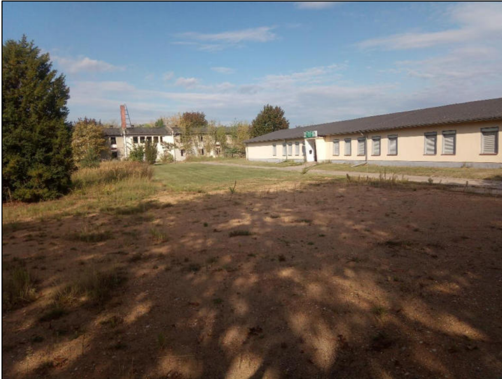
Bild 1: Blick auf ein noch genutztes Gebäude im zentralen Plangebiet. Auf der Fläche im Bildvordergrund wurde ein Gebäude abgerissen (September 2020)
