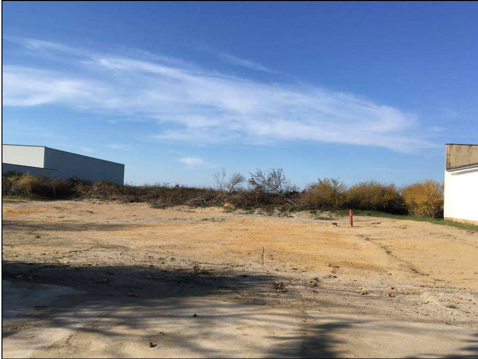
Bild 5: Im Nordwesten des Plangebietes wurden Gebäude abgebrochen und der Boden eingeebnet (April 2021).
