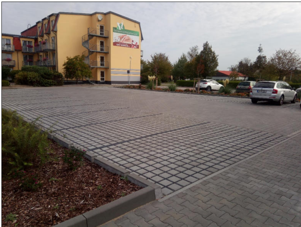
Bild 4: Blick über den neu angelegten Parkplatz am Sportpark Oschatz (Fitnessstudio); Blomberger Straße 7 (September 2020).
